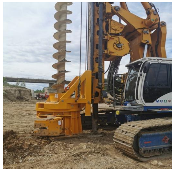
CFA piles \Phi 630\text{mm} , L=20,00\text{m}
