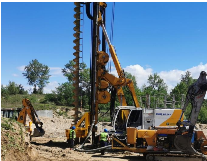
CFA piles \Phi 630\text{mm} , L=20,00\text{m}
